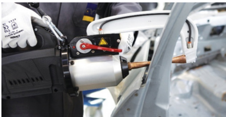
Rys. 10. Naprawa z wykorzystaniem zgrzewarki oporowej [2]
